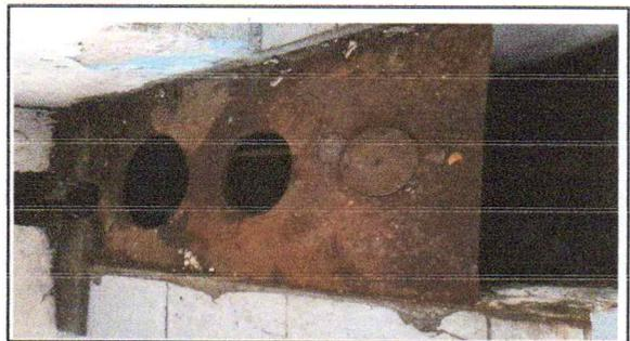
FOTO 12: Sustitución de plancha de metal de 3 hornillas
