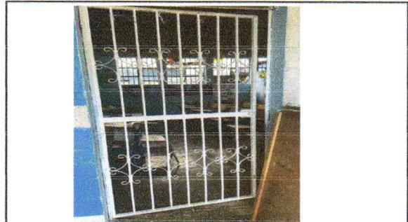
FOTO 8: Mantenimiento a estructura (lijado, cambio de tubo , cepillado, sujeciones, aplicación de pintura) PUERTAS EN AULAS
