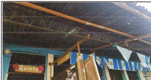
FOTO 6: Sustrucción de lámina, por lámina troquelada aluzinc calibre 26 AULAS
