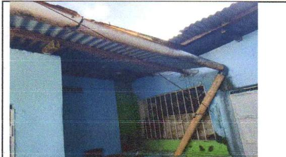
FOTO 3: Sustrucción de canal de metal Y Reparación de bajada de agua pluvial, tubo PVC 3"
